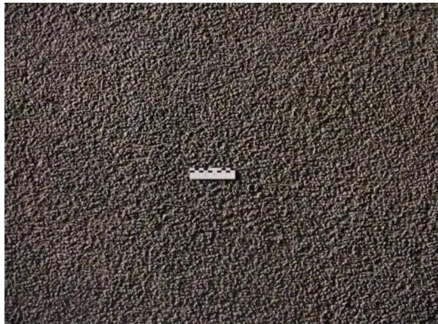
Результат ремонта цементобетонного покрытия по технологии "whitetopping" / "waschbeton"
